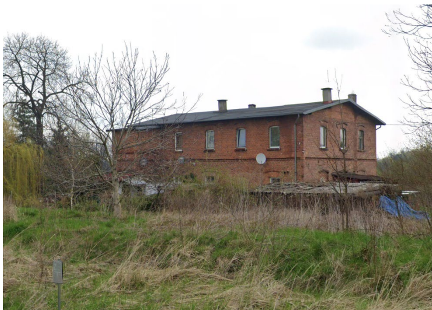
Rys. 2. Widok budynku przed przebudową ( https://www.google.pl/maps ).
