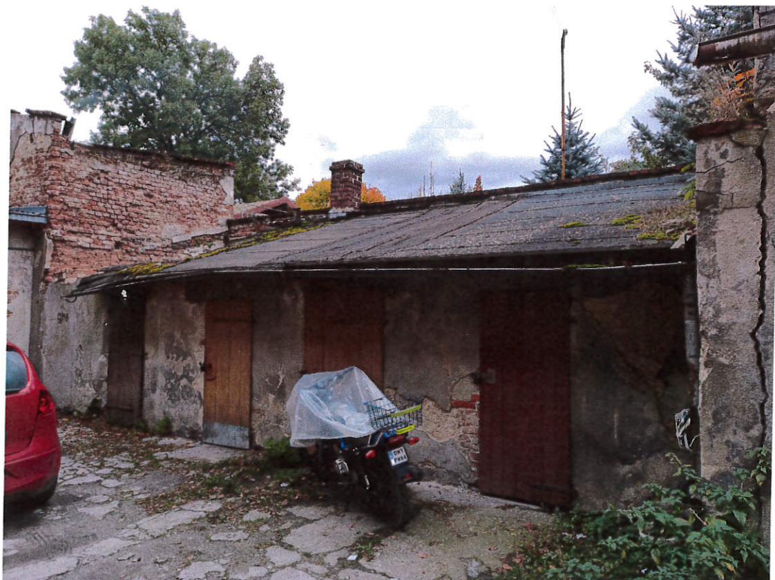
BUDYNEK GOSPODARCZY „G” - elewacja południowa i zachodnia
