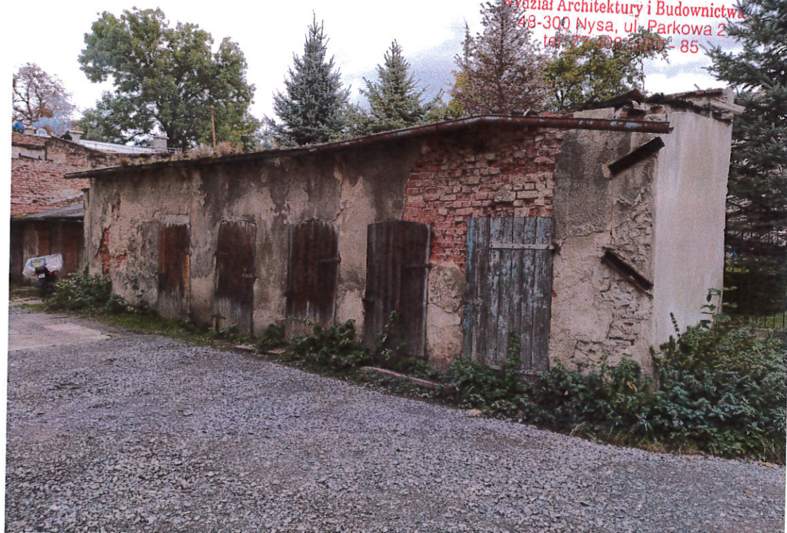
BUDYNEK GOSPODARCZY „G” - elewacja południowa i zachodnia
